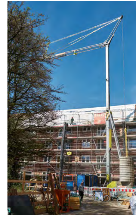
Momentaufnahme der Modernisierung im April: Die Balkone sind abgebaut, die Dacharbeiten im Gange.
